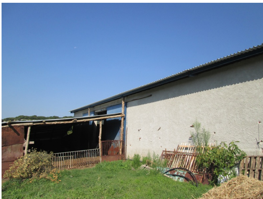
Εικόνα 10 Οι σταβλικές εγκαταστάσεις από μπροστά της μονάδας του κ Καντέρη.
