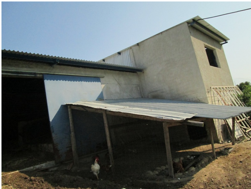
Εικόνα 11. Οι σταβλικές εγκαταστάσεις από μπροστά της μονάδας του κ Καντέρη.
