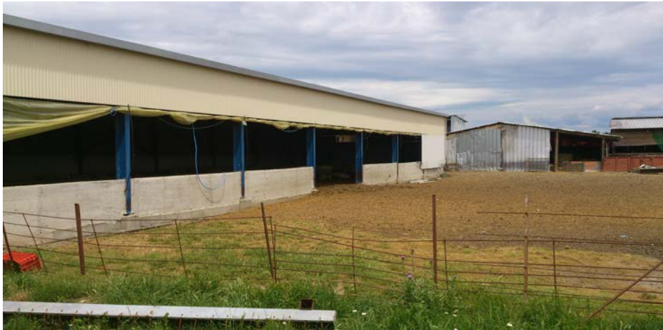
Εικ.56 Εξωτερική όψη των σταβλικών εγκαταστάσεων .
