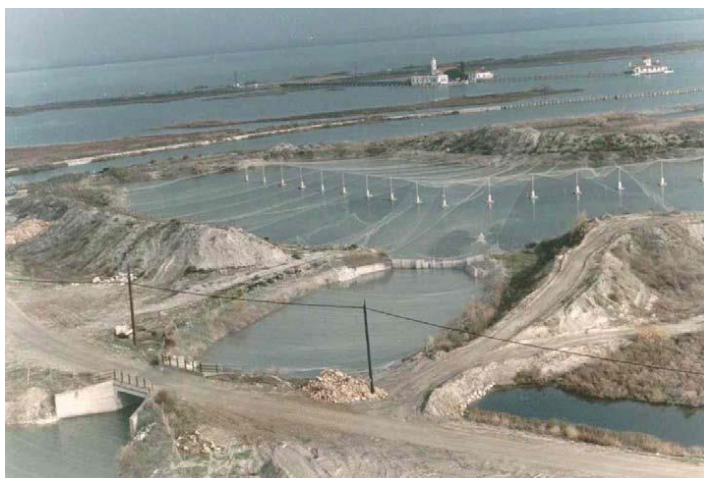
Δύο μονάδες για αντιπαγετική προστασία και θέρμανση τεχνητών λιμνών για ιχθυοκαλλιέργεια στο Πόρτο-Λάγος και στο Ν. Εράσμιο Ξάνθης
