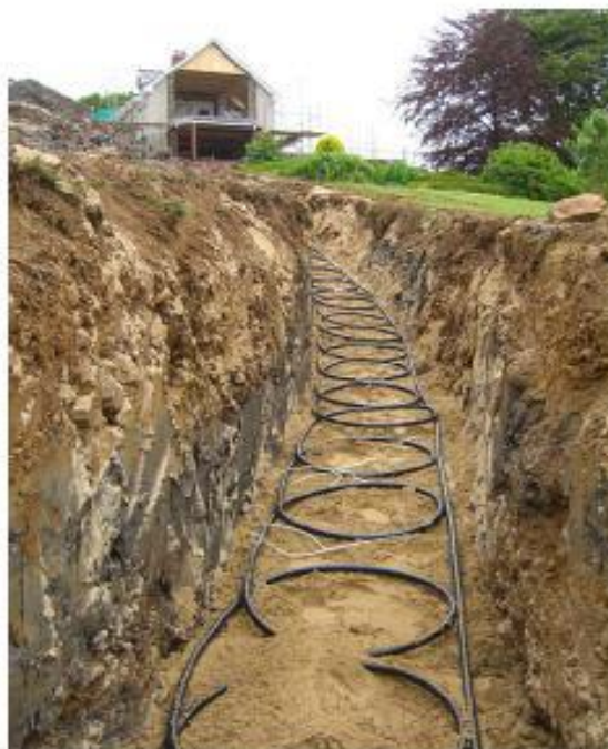
Υπόγεια εγκατάσταση συστήματος
