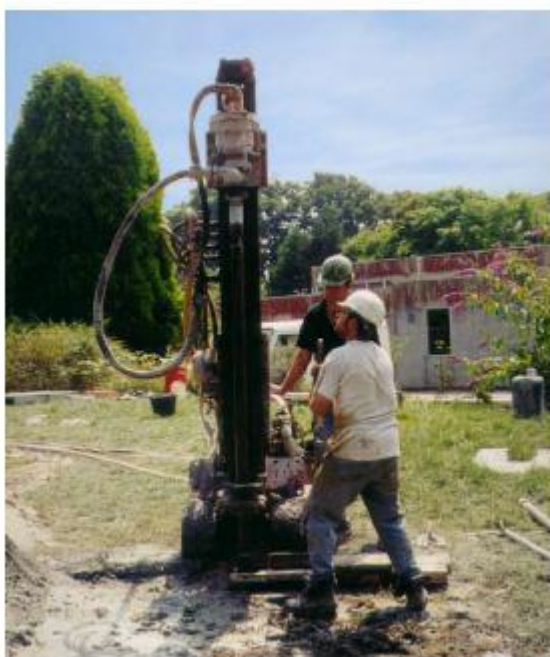
γεωτρύπανο για τη διάνοιξη γέωτρησης
