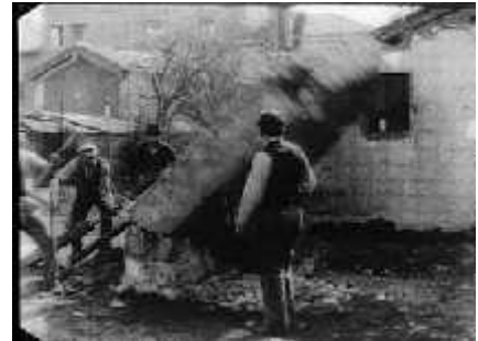
1 Demolition d' um mur
