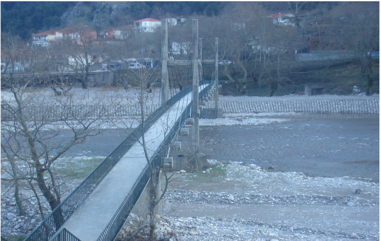
Κρεμαστή πεζογέφυρα στην Πύλη(1981)
