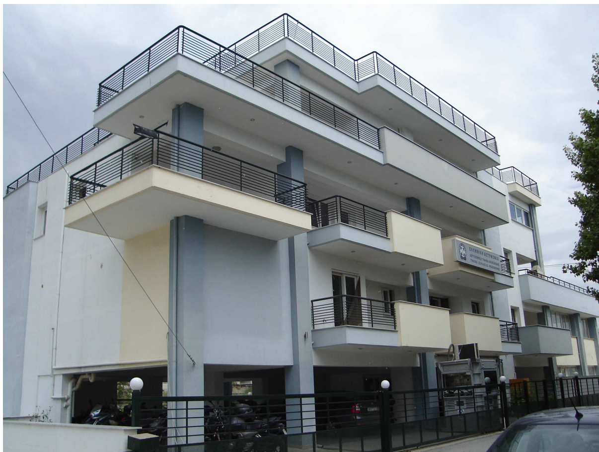
Εικόνα 11: Το κτίριο που συστεγάζονται το Αστυνομικό Τμήμα Μενεμένης και το Τμήμα Ασφαλείας Μενεμένης (Πηγή: Φίλη, 2009).
