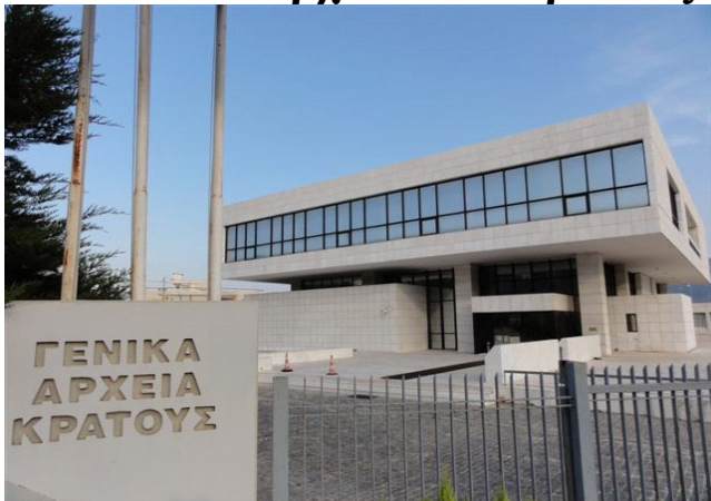
Εικόνα 1 : Νέο κτήριο των Γενικών Αρχείων του Κράτους στο Ψυχικό.
