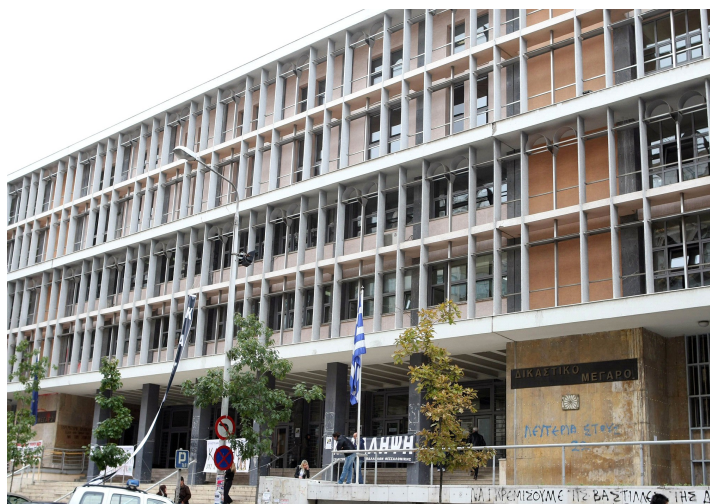
Εικόνα 3 : Κτήριο του Πρωτοδικείου Θεσσαλονίκης .
