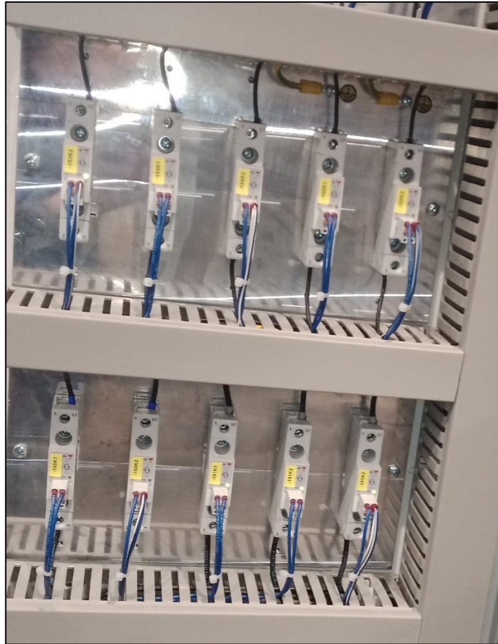
Εικόνα 3-11 Solid state relay από πίνακα extruder
