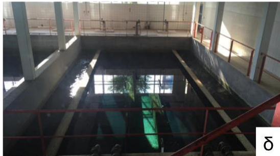
Εικόνα 3: (α) Δεξαμενή Δ2 (β) Δεξαμενή κροκιδοκαθίξεσης (γ) κλίνη άμμου (δ) κλίνη Άνθρακα
