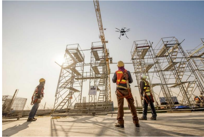
Εικόνα 26: Χαρτογράφηση κατασκευής με ΣμηΕΑ (Πηγή: Inspiredflight)
