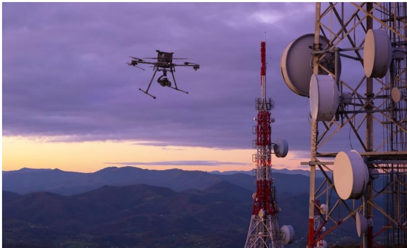
Εικόνα 27: Επιθεώρηση πύργων τηλεπικοινωνιών με ΣμηΕΑ (Πηγή: Inspiredflight)
