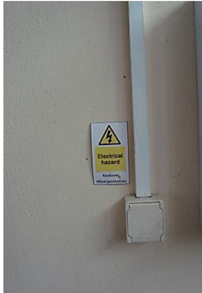
Εικόνα 3.3.6 Πινακίδα προειδοποίησης κινδύνου ηλεκτροπληξίας.
