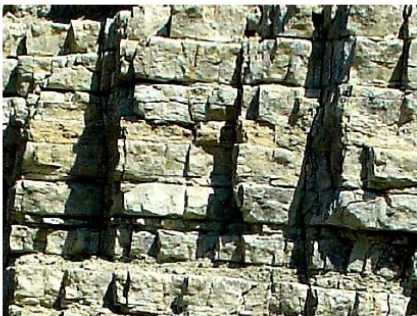
Εικόνα 1.1.1 Αποψη τυπικής ασυνεχούς βραχομάζας
