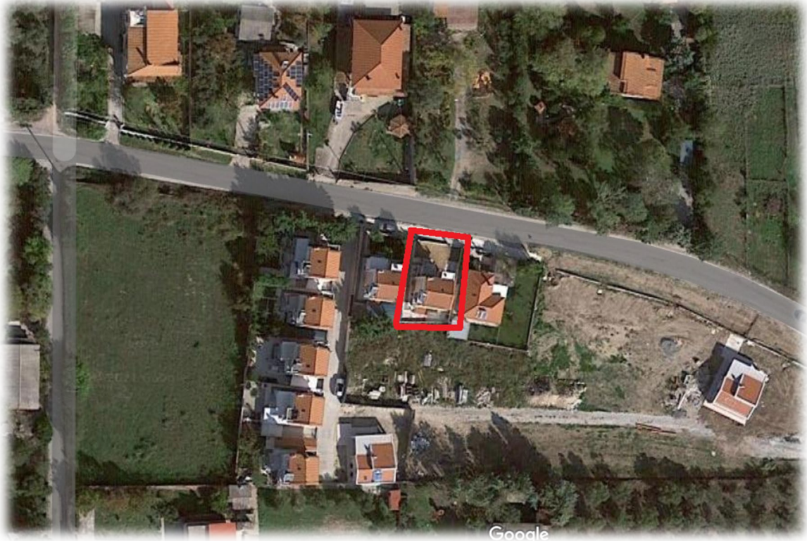
Εικόνα 2.1 : Το υπάρχων κτήριο που μελετάμε
