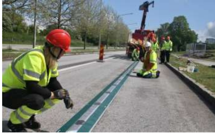
Εικόνα 17: Ηλεκτρική λωρίδα σε φάση κατασκευής στο Lund, Σουηδία (Evolution Road, 2020)
