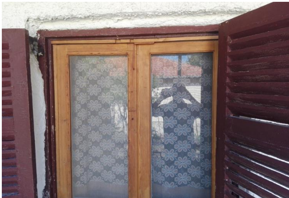
Εικόνα 9.1. Παλιό κούφωμα κατοικίας.
