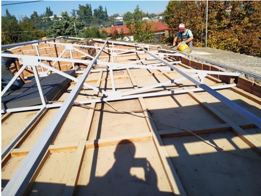
Εικόνα 8.7: Αρχικό στάδιο εργασιών μόνωσης στέγης
