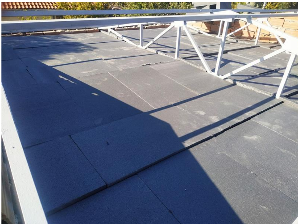
Εικόνα 9.8. Τελικό στάδιο εργασιών μόνωσης στέγης.
