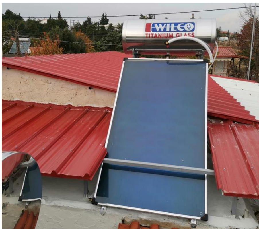
Εικόνα 9.9. Τοποθέτηση ηλιακού συλλέκτη.
