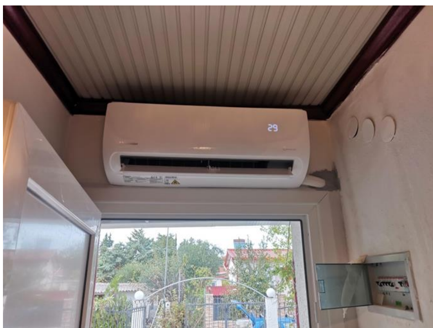
Εικόνα 9.10. Τοποθέτηση Α/Θ αέρα - αέρα.
