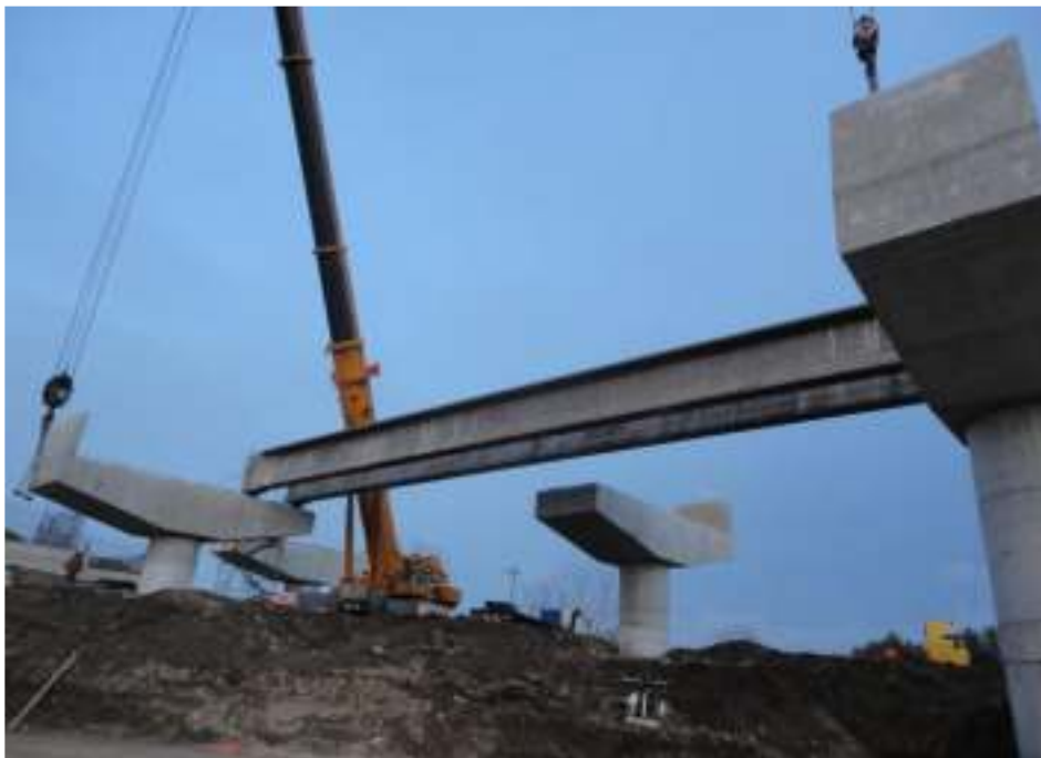
Εικόνα 4. Μέθοδος Προκατασκευασμένων Δοκών
