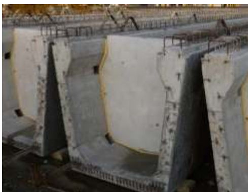
Εικόνα 6. Διατομή “Banagher W Beam”
