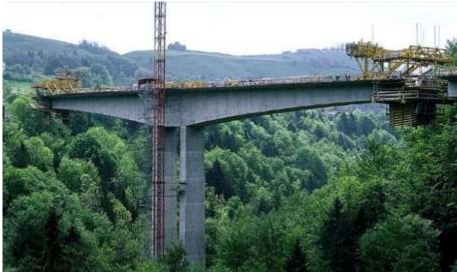
Εικόνα 1. Μέθοδος Προβολοδόμησης
