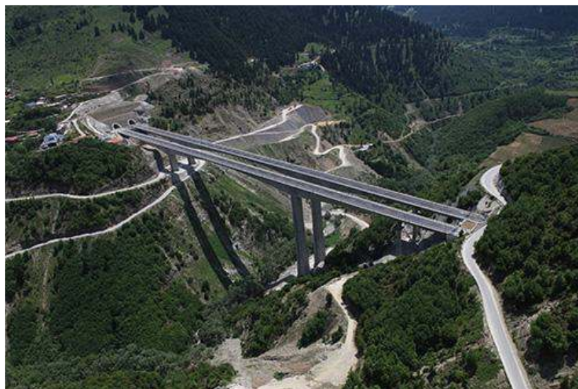
Εικόνα 14. Γέφυρα Μετσοβίτικου ποταμού
