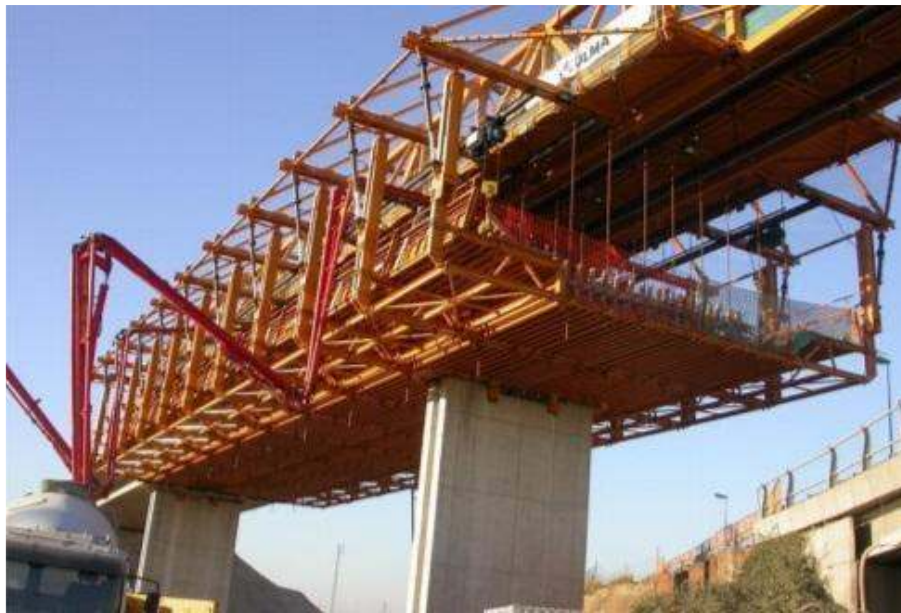
Εικόνα 3. Μέθοδος Προωθούμενων – Αυτοφερούμενων Δοκών
