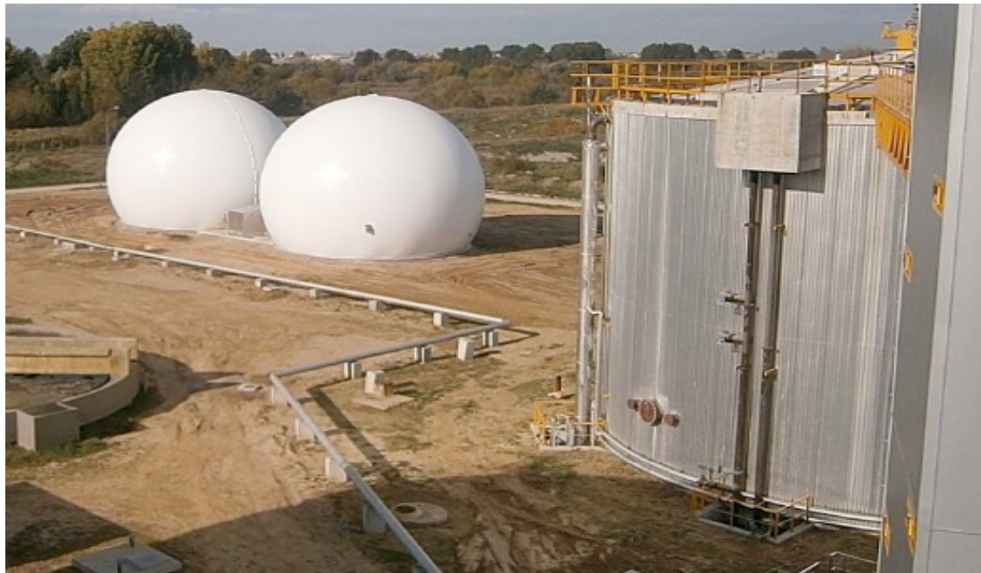
Εικόνα 15. Χωνευτής της ΕΕΛΘ και στο βάθος τα δύο αεριοφυλάκια βιοαερίου.
