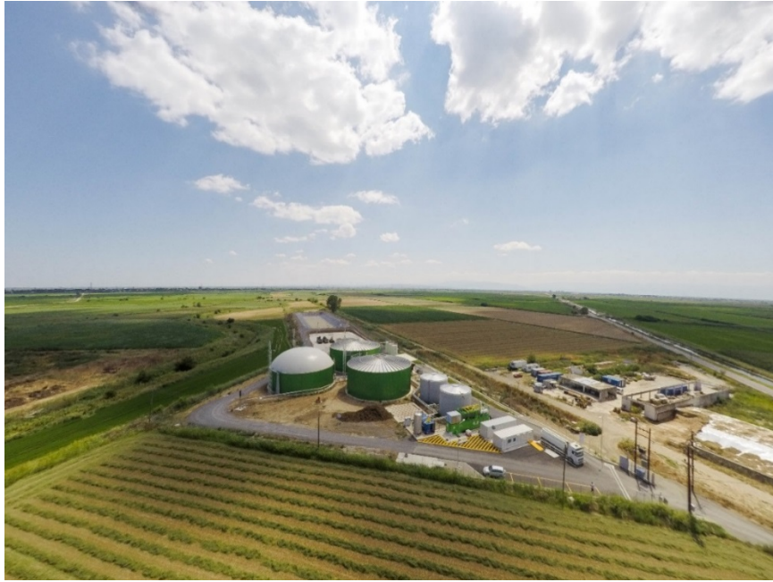
Εικόνα 14. Μονάδα παραγωγής βιοαερίου και ηλεκτρικής Ενέργειας (IMW) με χρήση βοοειδών αποβλήτων αραιωμένα με ενσίρωμα καλαμποκιού (ΤΕΡΝΑ- ΕΝΕΡΓΕΙΑΚΗ)
