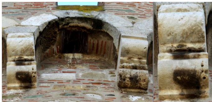
Εικόνα 95. Δ-ΒΔ όψη (291 ο ): Γυψοποίηση και μαύρη κρούστα στα φουρούσια.
