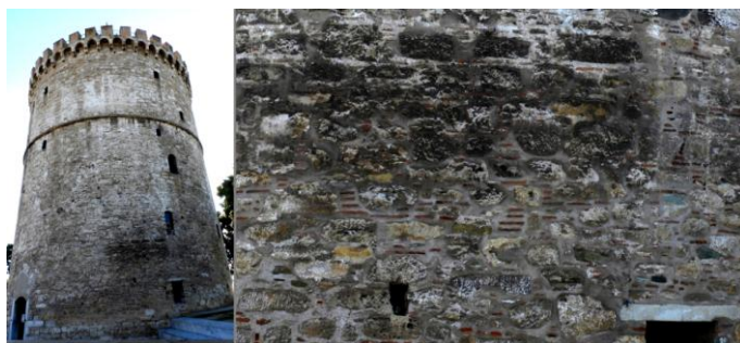
Εικόνα 96. Β όψη: Μαύρες χαλαρές αποθέσεις.
