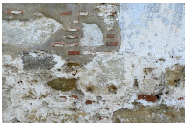
Εικόνα 89. Υπολείμματα παλιών επιχρισμάτων.
