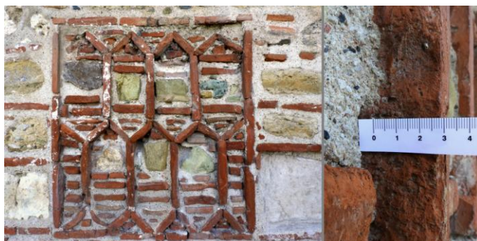
Εικόνα 94. Δ όψη: Κεραμικός Διάκοσμος. Απόσπαση κόκκων, οπισθοχώρηση επιφάνειας, επικαθίσεις στις πλίνθους.
