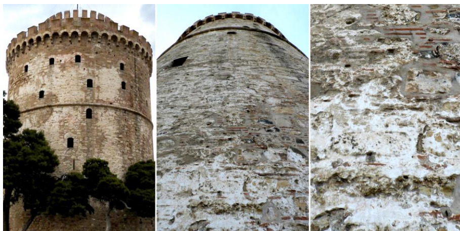
Εικόνα 92. Ν-ΝΑ όψη: Υπολείμματα επιχρισμάτων, λευκή κρούστα.
