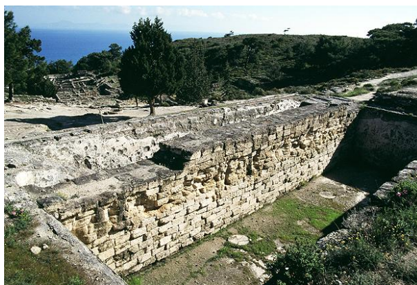
Εικόνα 12. Κάμιρος Ρόδου, δεξαμενή θηραϊκού σκυροδέματος. (Πηγή: ΥΠΠΟ, 2012)
