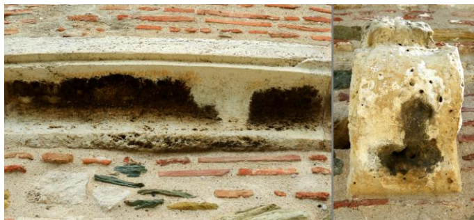
Εικόνα 97. Πυργίσκος: Γυψοποίηση και μαύρη κρούστα σε φουρούσια και γείσο.
