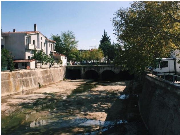
Εικόνα 21: Υφιστάμενη κατάσταση του οικισμού Βασιλικών γύρω από την κοίτη του ποταμού
