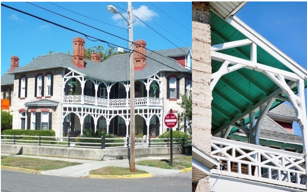
Εικόνα 5. Κτίριο κατασκευασμένο εν έτη 1885 με τεχνική Tabby στην παραλία Φερναντίνα της Φλόριντα (Πηγή: https://en.wikipedia.org/wiki/Tabby_House_(Fernandina_Beach,_Florida) )
