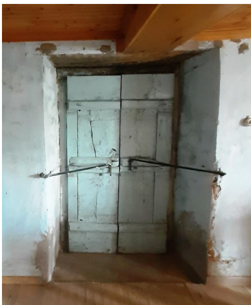
Εικ. 57) Εσωτερική άποψη της εξώθυρας και παραδοσιακός τρόπος ασφαλείας από το εσωτερικό του Ι. Ν. Αγίου Αντωνίου.
