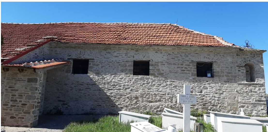
Εικ. 49) Εξωτερική άποψη από τον Ι. Ν. Αγίου Αθανασίου ο οποίος αποτελεί τον χώρο τον κοιμητηρίων.
