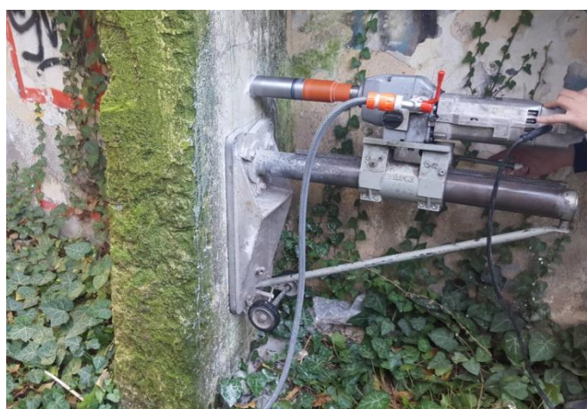
Εικόνα 26: Καροτιέρα έτοιμη για χρήση
