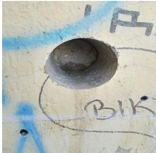
Εικόνα 28: Τοίχος μετά την λήψη πυρήνα διαμέτρου 10 cm
