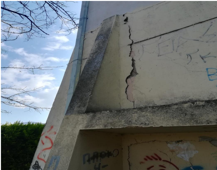
Εικόνα 16: Σημαντικές ζημιές σε αντηρίδες
