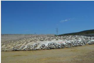
Εικόνα 23. Αποθηκευτικός χώρος συμπυκνωμένων ζωοτροφών
