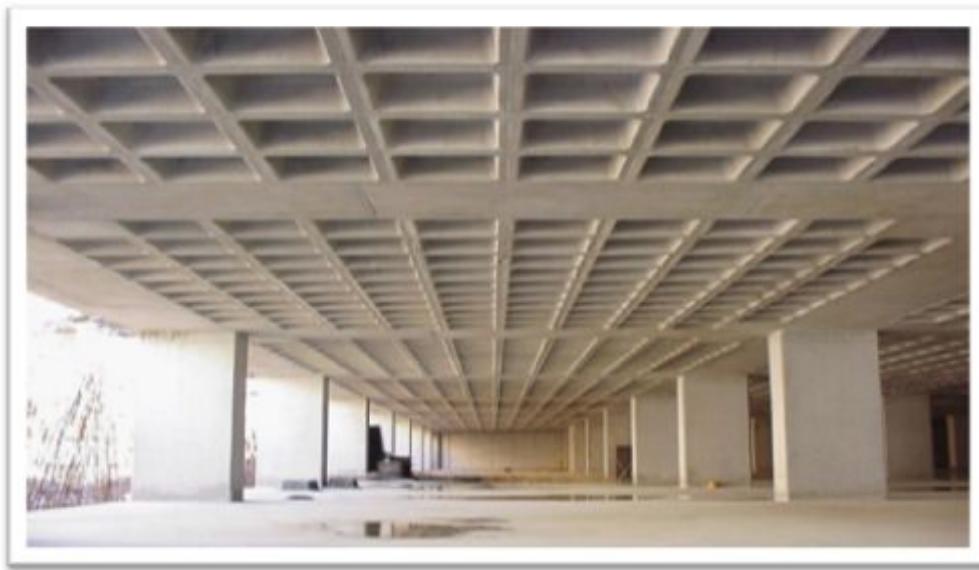
Σχήμα 3: Πλάκα νευρώσεις από οπλισμένο σκυρόδεμα.
