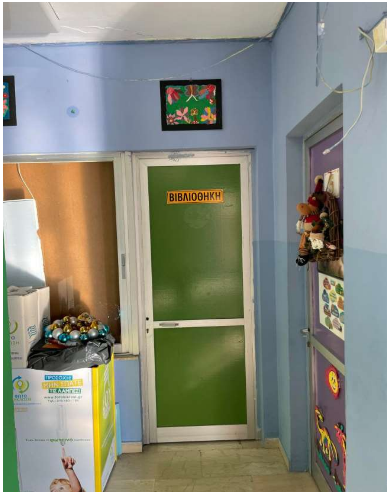
Εικόνα 15: Χώρος παλαιάς βιβλιοθήκης
