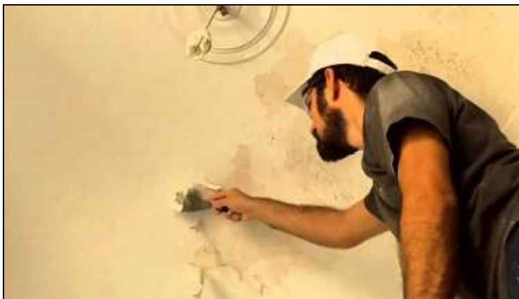
Εικόνα 52 Καθαίρεση επιχρίσματος
