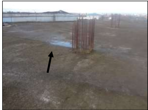
Εικόνα 27 Στάσιμο νερό στην οροφή του κτιρίου
