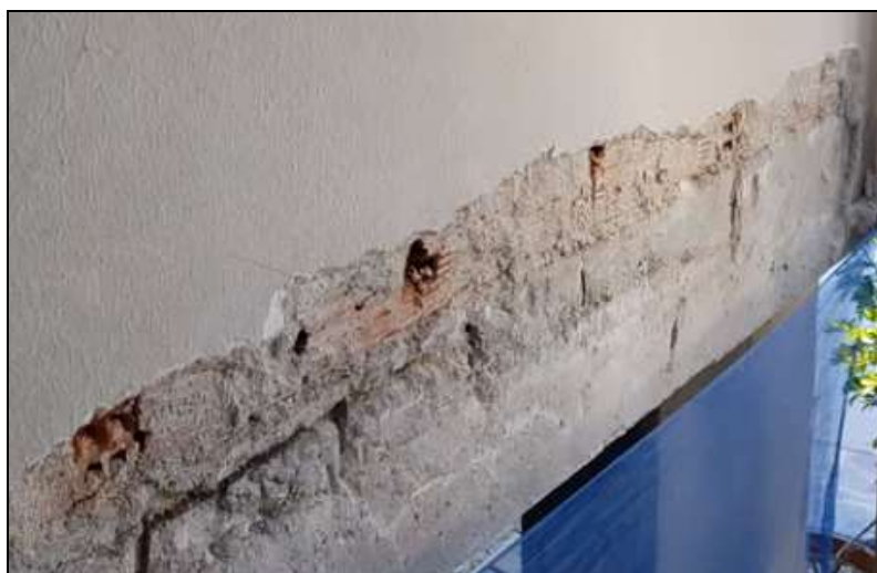
Εικόνα 54 Καθαίρεση επιχρίσματος τοιχοποιίας
