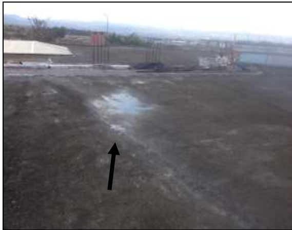
Εικόνα 27 Στάσιμο νερό στην οροφή του κτιρίου
