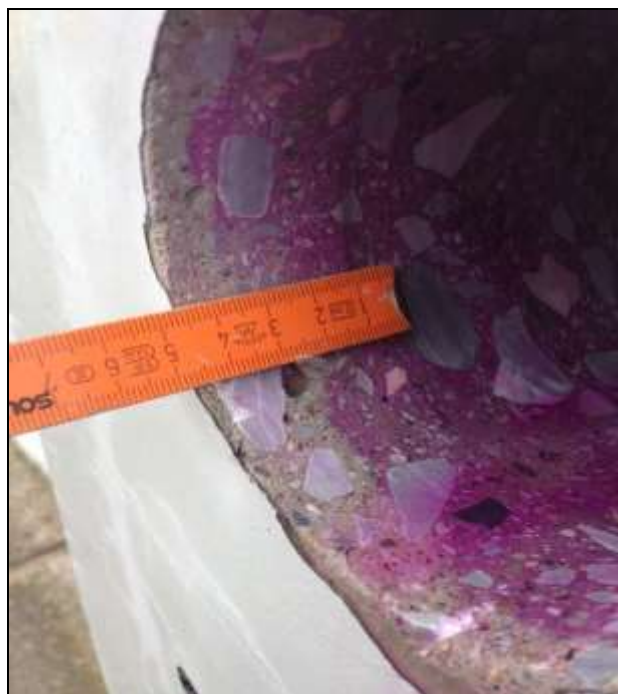
Εικόνα 41 Μέτρηση βάθους ενανθράκωσης
