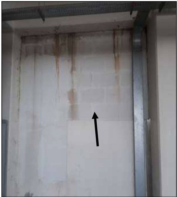
Εικόνα 16 Επίδραση απορροής νερού
