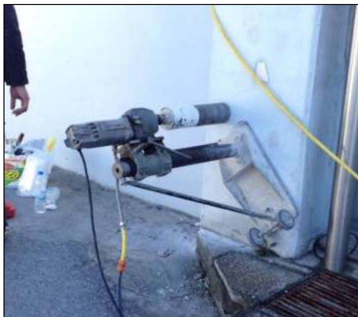
Εικόνα 40 Τοποθέτηση Καροτιέρας
