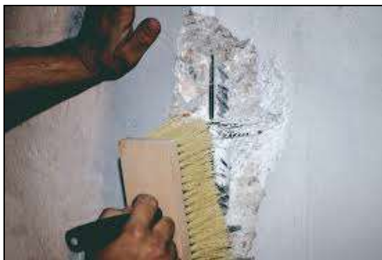
Εικόνα 51 τρίψιμο οπλισμού με βούρτσα
