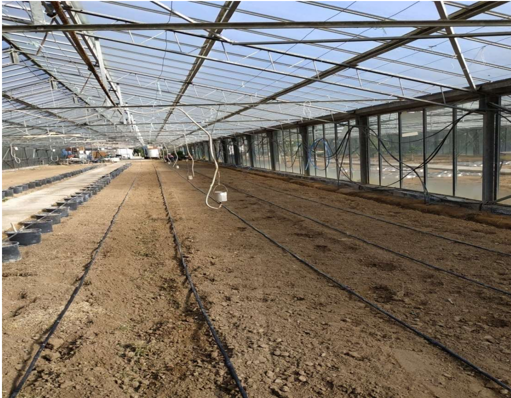
Εικόνα 11: Τοποθέτηση αντιστάσεων πριν την φύτευση ( Πηγή Τ.Β. )
