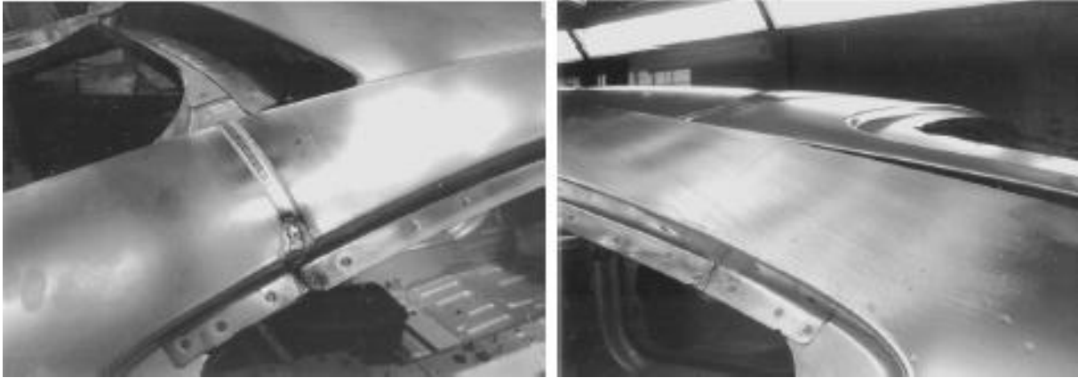
Εικόνα 103 – Συγκόλληση μεσαίας κολώνας με την οροφή μέσω αυτοματοποιημένης παλμικής ηλεκτροσυγκόλλησης MIG [42]
