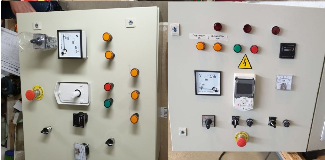
Τοποθέτηση υλικών πάνω στην πόρτα και καλωδίωση πόρτας.
