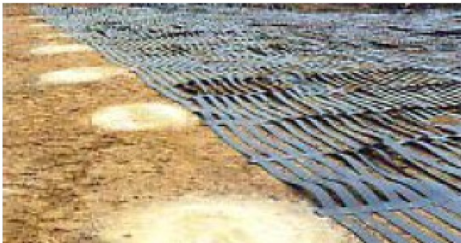
Εικόνα 2.7: Ενίσχυση εδάφους με τοποθέτηση γεωπλέγματος.
