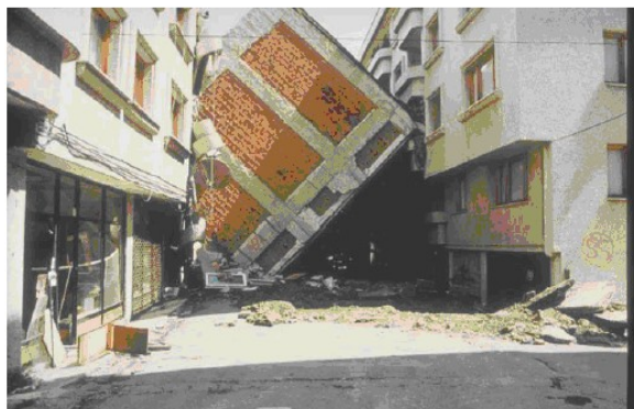
Εικόνα 2.17: Κατάρρευση κτιρίου από αστοχία εδάφους στην περιοχή Ιζμίτ της Τουρκίας το 1999.
