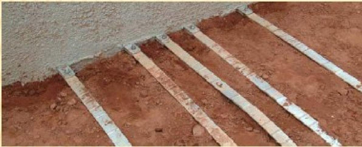
Εικόνα 2.4: Ενίσχυση εδάφους με τοποθέτηση μεταλλικών ελασμάτων.
