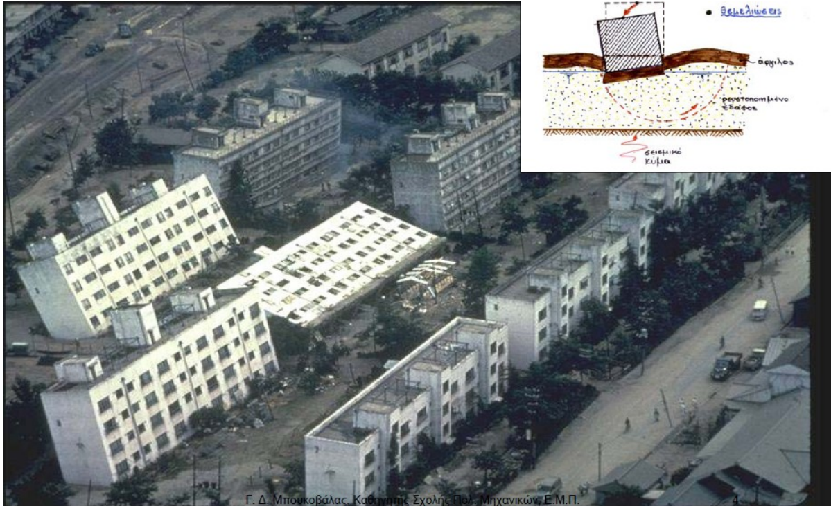
Εικόνα 2.19: Κατάρρευση κτιρίων από αστοχία εδάφους στην περιοχή Niigata Ιαπωνίας το 1964.
