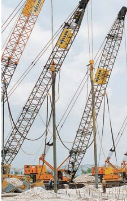
Εικόνα 2.9: Εφαρμογή Δυναμικής Συμπύκνωσης
