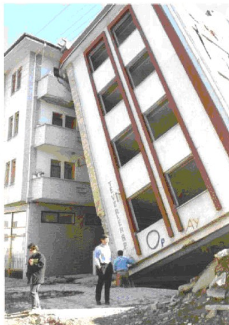
Εικόνα 2.17: Κατάρρευση κτιρίου από αστοχία εδάφους στην περιοχή Ιζμίτ της Τουρκίας το 1999.
