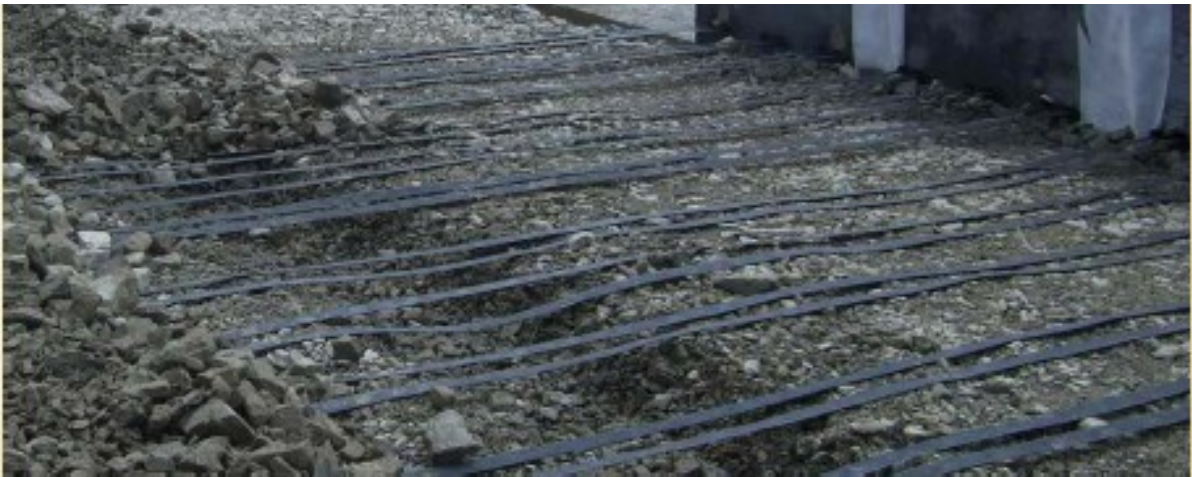
Εικόνα 2.5: Ενίσχυση εδάφους με τοποθέτηση μεταλλικών ελασμάτων.
