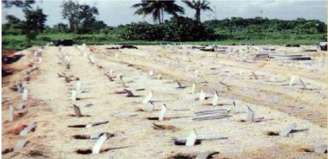
Εικόνα 2.14: Εφαρμογή της βελτίωσης εδάφους με κατακόρυφα στραγγιστήρια.
