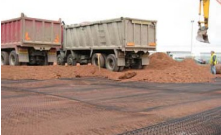
Εικόνα 2.6: Ενίσχυση εδάφους με τοποθέτηση γεωφάσματος.
