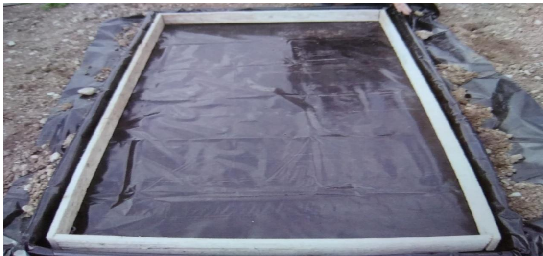
Τοποθέτηση Εσωτερικού Πλαισίου
