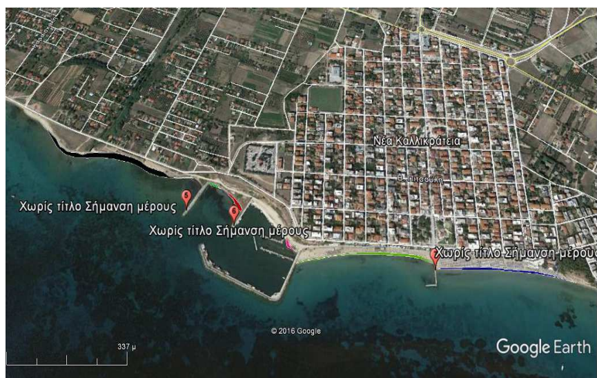
Εικόνα 32: Το λιμάνι της Νέας Καλλικράτειας σε αεροφωτογραφία του έτους 2015 με εμφανείς τις επιδράσεις στην παραλιακή ζώνη. Πηγή: Google Earth.
