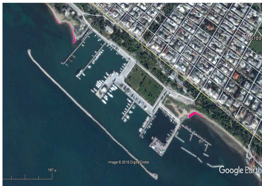
Εικόνα 18: Η μαρίνα της Θεσσαλονίκης σε αεροφωτογραφία του έτους 2015 με εμφανείς της επιδράσεις στην παραλιακή ζώνη. Πηγή: Google Earth
