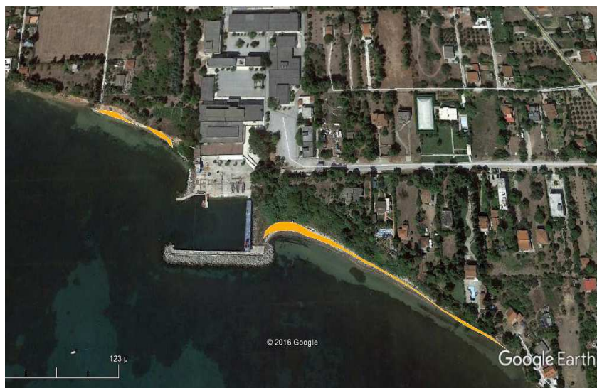
Εικόνα 24: Το λιμάνι της ακαδημίας εμπορικού ναυτικού σε αεροφωτογραφία του έτους 2015 με εμφανείς τις επιδράσεις στην παραλιακή ζώνη. Πηγή: Google Earth.
