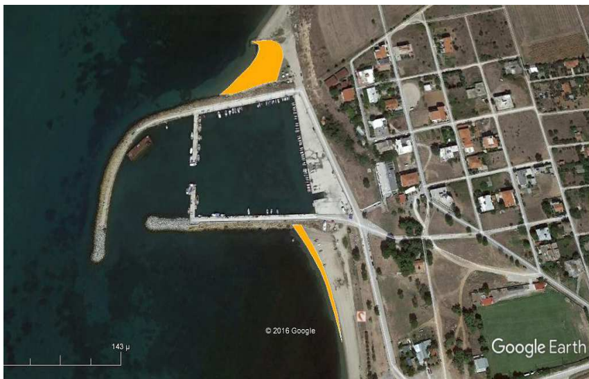
Εικόνα 22: Το αλιευτικό καταφύγιο Αγγελοχωρίου σε αεροφωτογραφία του έτους 2015 με εμφανείς τις επιδράσεις στην παραλιακή ζώνη. Πηγή: Google Earth.
