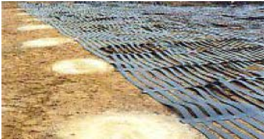
Εικόνα 2.7: Ενίσχυση εδάφους με τοποθέτηση γεωπλέγματος.
