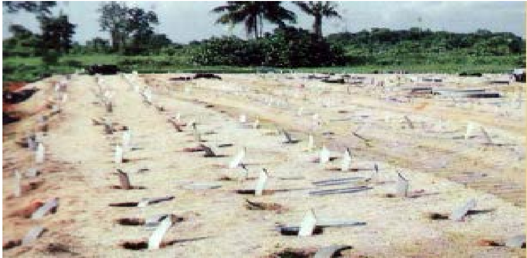
Εικόνα 2.14: Εφαρμογή της βελτίωσης εδάφους με κατακόρυφα στραγγιστήρια.
