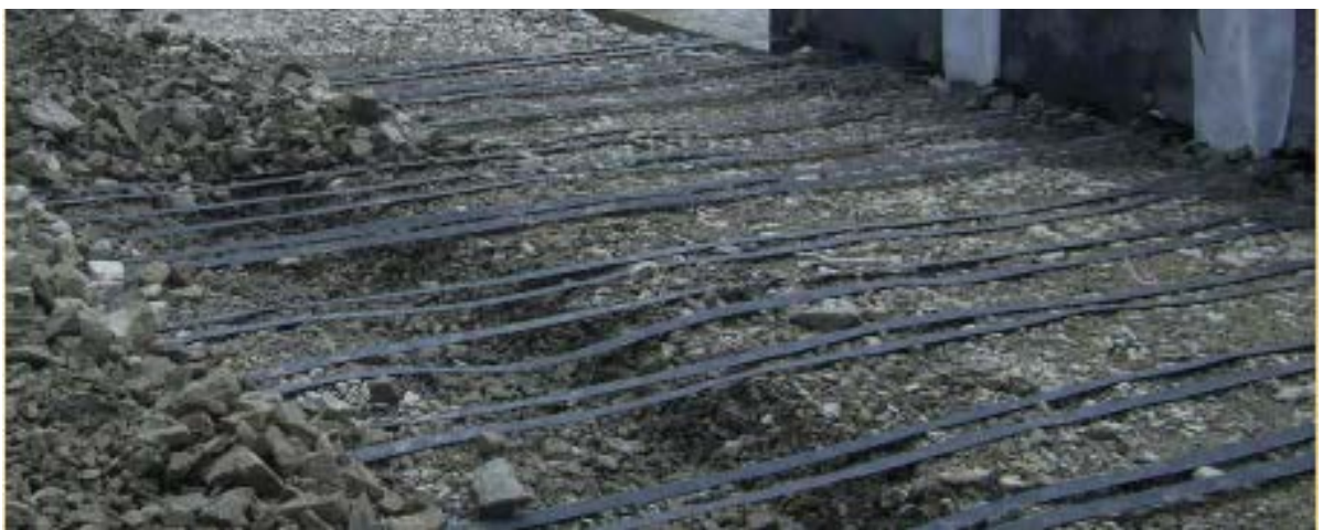
Εικόνα 2.5: Ενίσχυση εδάφους με τοποθέτηση μεταλλικών ελασμάτων.
