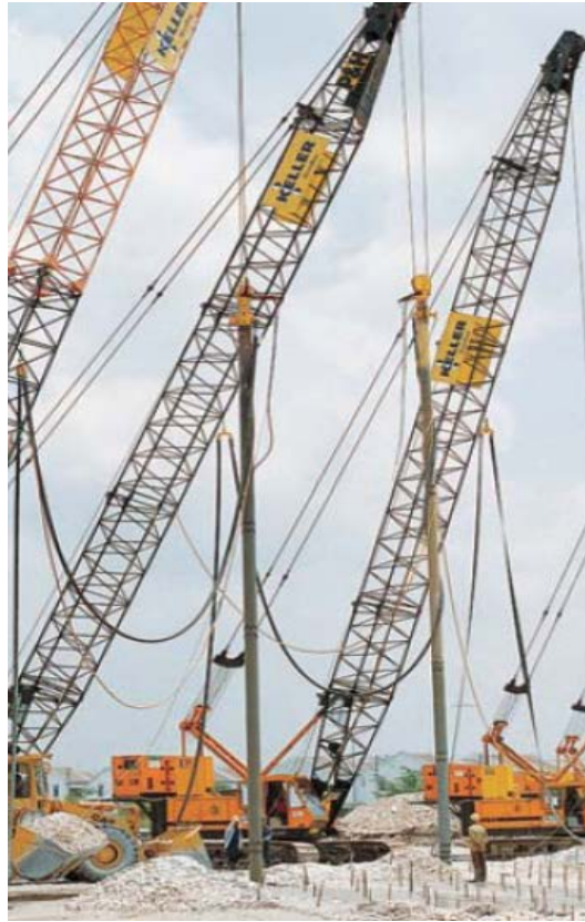
Εικόνα 2.9: Εφαρμογή Δυναμικής Συμπύκνωσης
