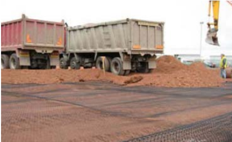
Εικόνα 2.6: Ενίσχυση εδάφους με τοποθέτηση γεωφάσματος.
