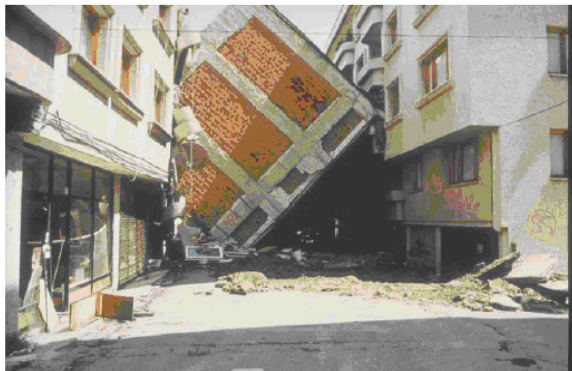
Εικόνα 2.17: Κατάρρευση κτιρίου από αστοχία εδάφους στην περιοχή Izmit της Τουρκίας το 1999.
