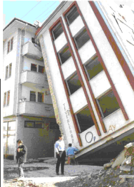
Εικόνα 2.17: Κατάρρευση κτιρίου από αστοχία εδάφους στην περιοχή Izmit της Τουρκίας το 1999.
