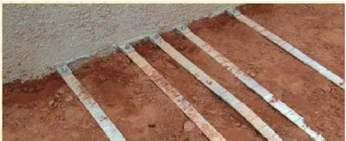
Εικόνα 2.4: Ενίσχυση εδάφους με τοποθέτηση μεταλλικών ελασμάτων.
