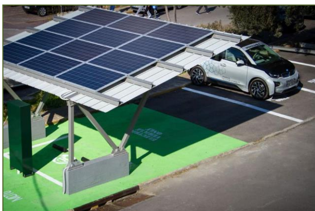
Εικόνα 32: Ηλιακός σταθμός ηλεκτρικών αυτοκινήτων, (πηγή: kathimerini.gr)
