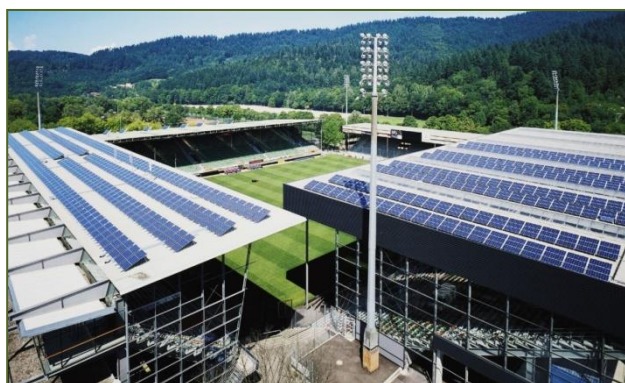
Εικόνα 8: Ηλιακά πάνελ στην οροφή του "Schwarzwald Stadion", (πηγή: Freiburg.de)
