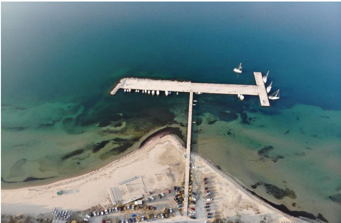
Εικόνα 93 : Σημερινή μορφή του έργου (drone 10-11-2018)
