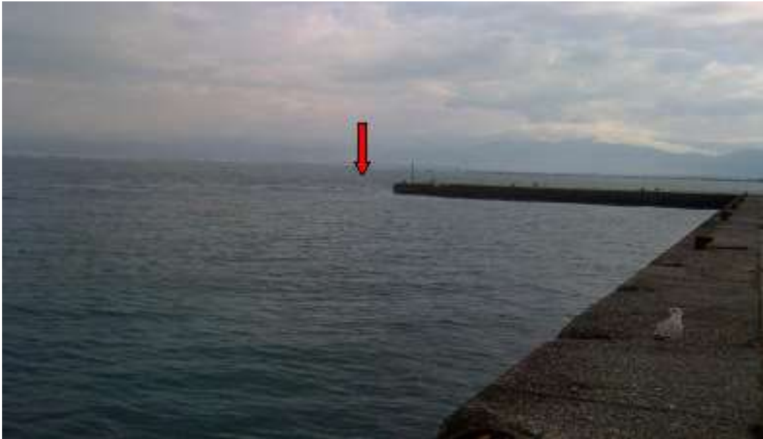
Εικόνα 29 : Καθίζηση του κάθετου προβλήτα του κυματοθραύστη (17-10-2016) Πηγή : Τσεμπεκίδης, 2017
