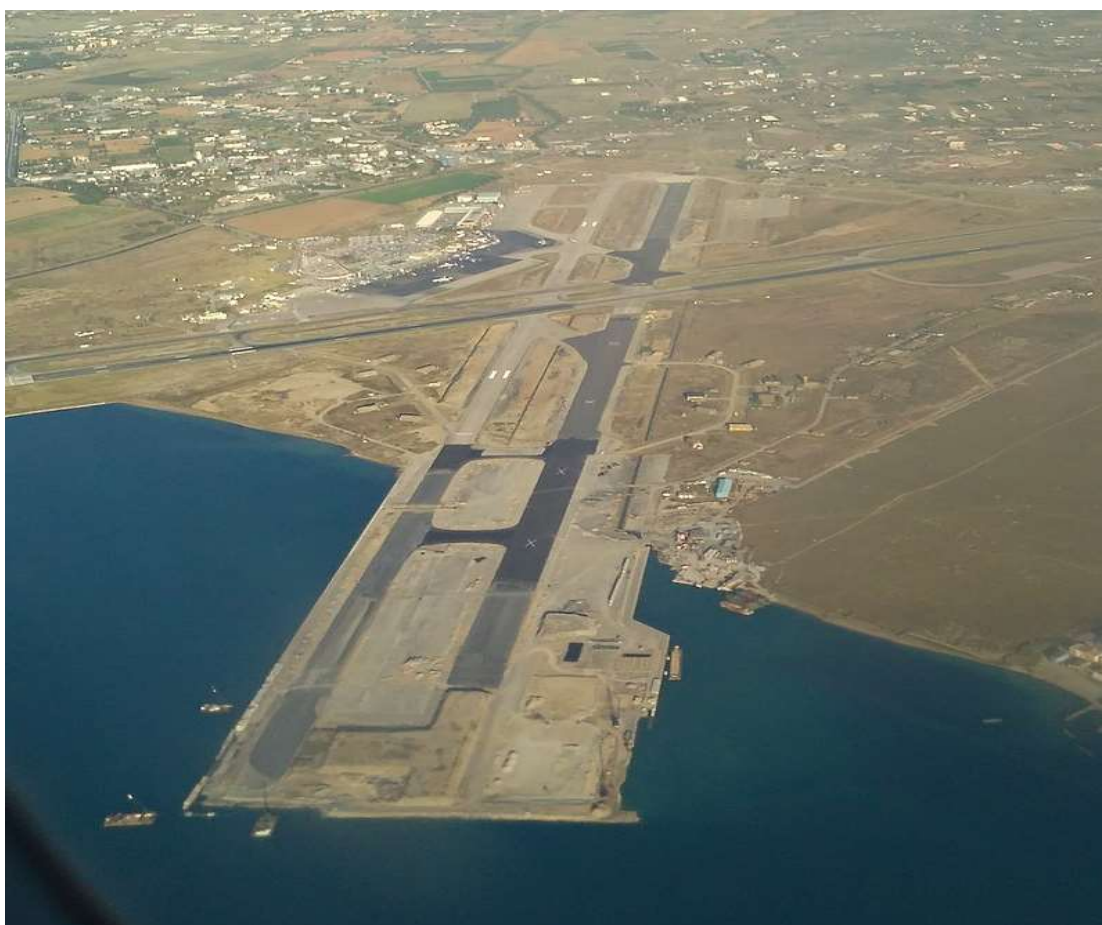
Εικόνα 25 : επέκταση 1 km του αεροδιαδρόμου 10/28 του αερολιμένα Μακεδονίας. Πηγή : Διαδικτυακή εγκυκλοπαίδεια ελεύθερου περιεχομένου Wikipedia. Διεθνής κρατικός αερολιμένας Θεσσαλονίκης «Μακεδονία».
