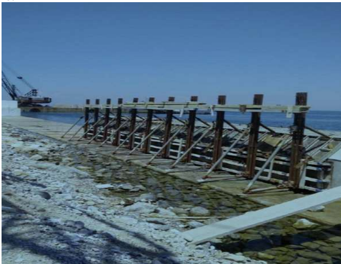
Εικόνα 26 : Επιχώσεις στο θαλάσσιο τμήμα για την επέκταση στου αεροδιαδρόμου 10/28 Πηγή : Αγώνας δρόμου για να παραδοθεί ο διάδρομος 10/28 του «Μακεδονία» https://www.voria.gr/article/agonas-dromou-gia-na-paradothi-o-diadromos-1028-tou-makedonia
