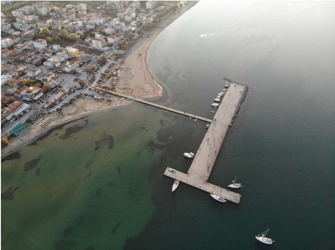
Εικόνα 94 : Σημερινή μορφή του έργου (drone 10-11-2018)
