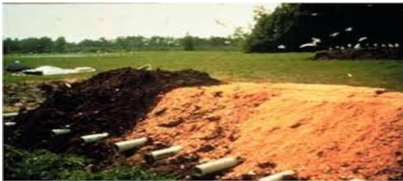
Εικόνα 8 Τοποθέτηση Αεραγωγών ( http://www.eclass.teipel.gr/eclass2 )
