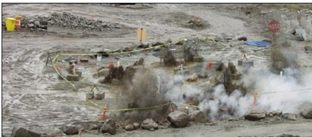
Σχήμα 3.17 Βελτίωση εδαφών έναντι ρευστοποίησης με ελεγχόμενες εκρήξεις
