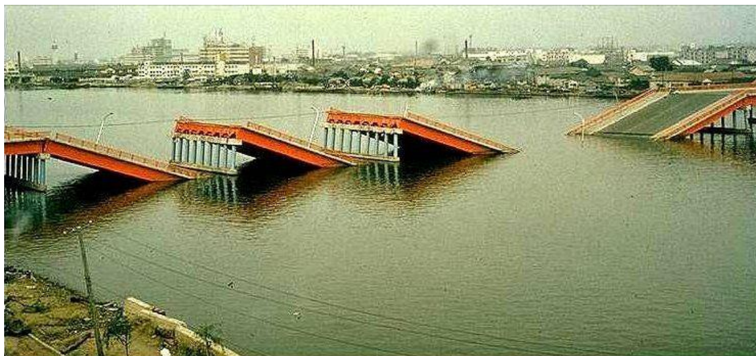
Σχήμα 2.19 Αστοχία γέφυρας στη Niigata της Ιαπωνίας ως αποτέλεσμα πλευρικής εξάπλωσης (1964).
