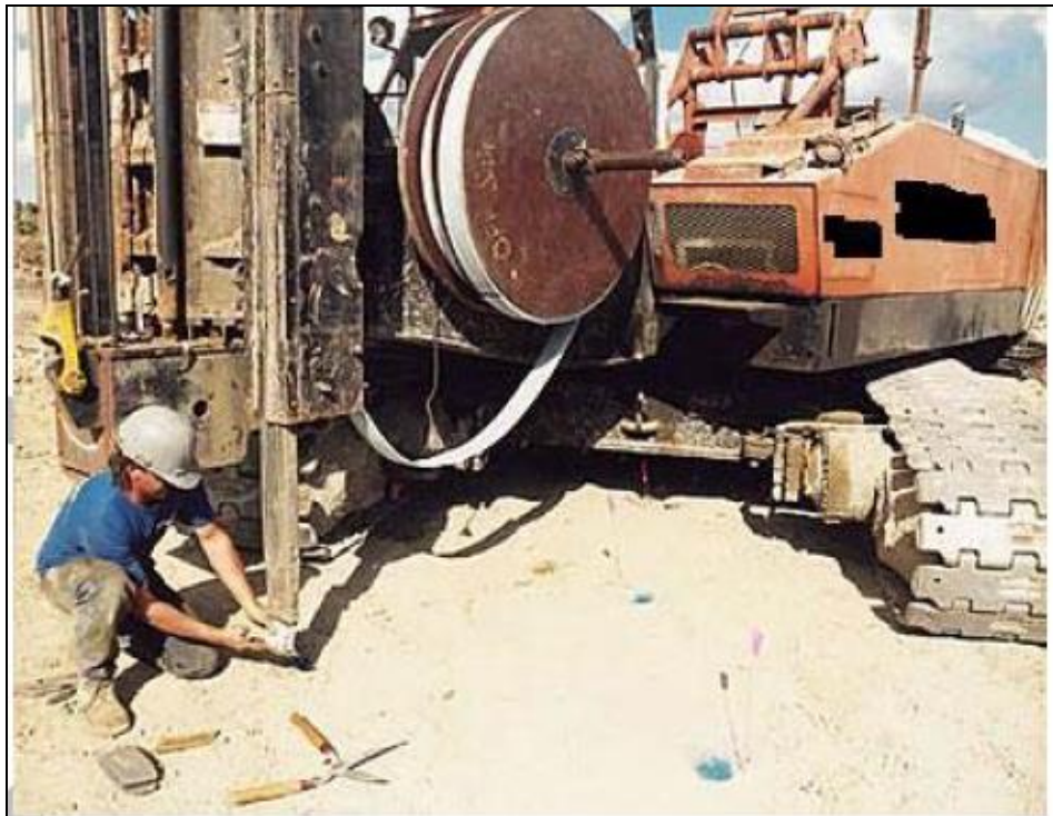
Σχήμα 3.3 Εξοπλισμός τοποθέτησης κατακόρυφων στραγγιστηρίων (ΠΕΤΕΠ 11-03-06-00)
