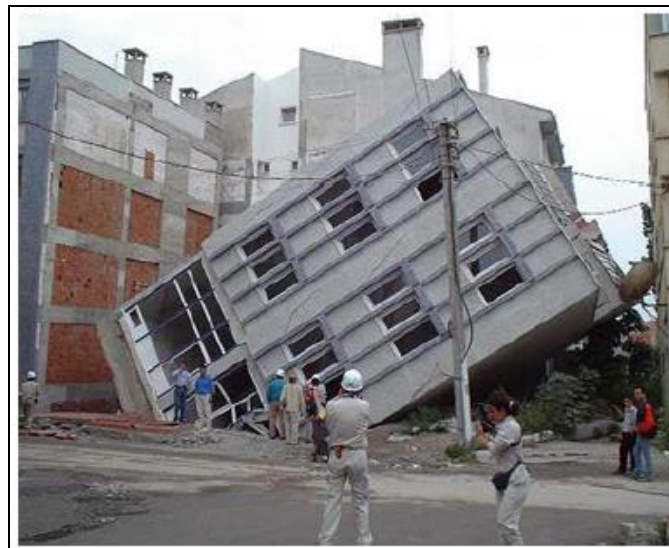
Σχήμα 2.9 Κατάρρευση κτιρίου λόγω ρευστοποίησης του εδάφους θεμελίωσης από τον σεισμό στο Kocaeli της Τουρκίας το 1999.
