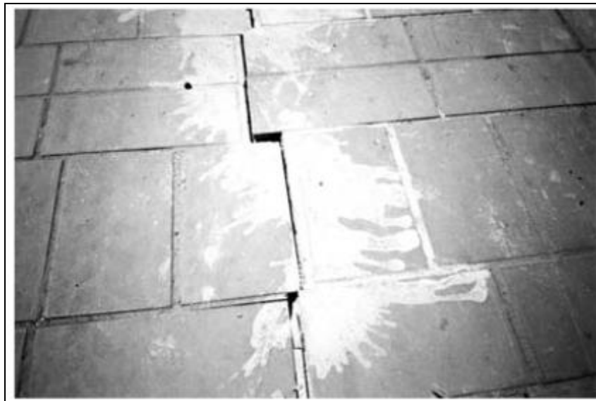
Σχήμα 2.16 Ανάδυση λεπτόκοκκου υλικού σε θέση ρευστοποίησης στη Λευκάδα (Παπαθανασίου κ.α., 2004).
