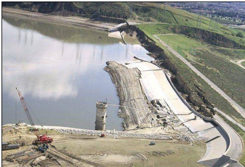
Σχήμα 2.4 Καταστροφή του φράγματος Lower San Fernando, ως αποτέλεσμα ρευστοποίησης με μορφή εδαφικής ροής μετά το σεισμό του San Fernando, California (1971).
