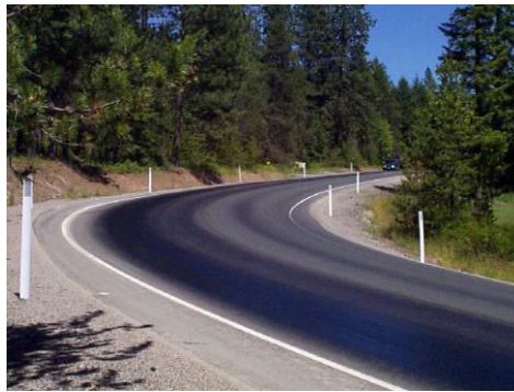
Εικόνα 2.15: Ανάδυση ασφάλτου λόγω υπερβολικής ποσότητας ασφάλτου
