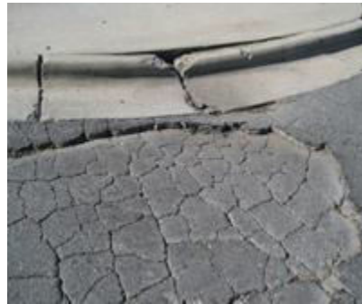
Εικόνα 2.13: Αποφλοιώση οδοστρώματος
