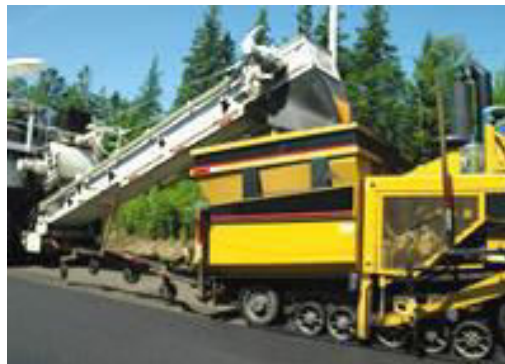
Εικόνα 3.5: Απόξεση οδοστρώματος (Planing)
