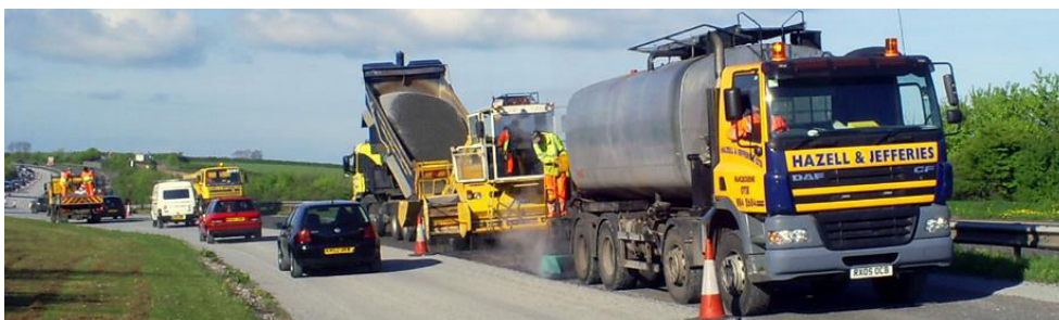
Εικόνα 3.9: Διάστρωση ασφαλτικής επίστρωσης
