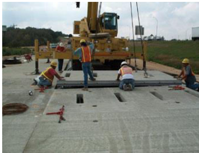
Εικόνα 4.1: Τοποθέτηση προκατασκευασμένου πάνελ από σκυρόδεμα
