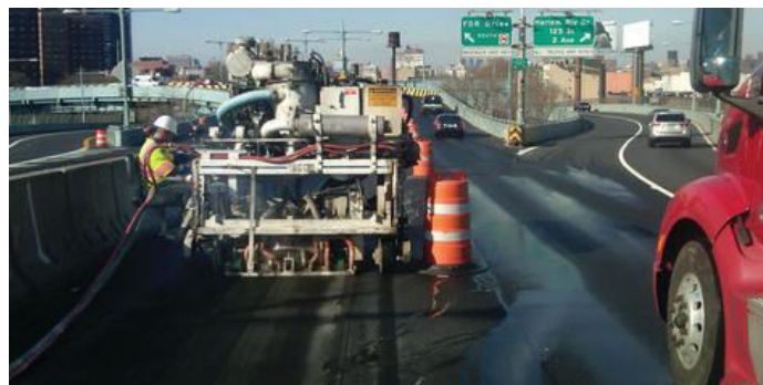
Εικόνα 3.3: Χάραξη – πριονισμός οδοστρώματος (Grooving)
