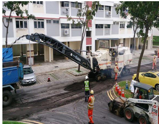
Εικόνα 3.2: Χάραξη – εκτομή οδοστρώματος (Milling)
