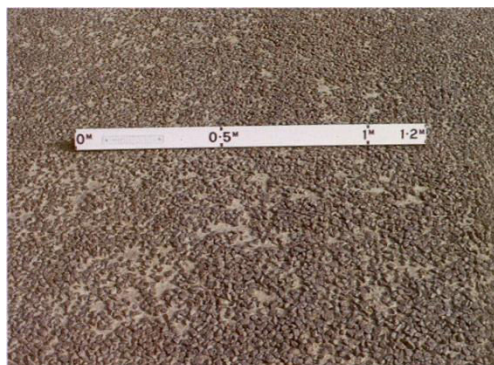
Εικόνα 2.14: Διάβρωση οδοστρώματος
