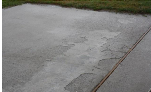
Εικόνα 2.17: Θρυμματισμός των πλακών
