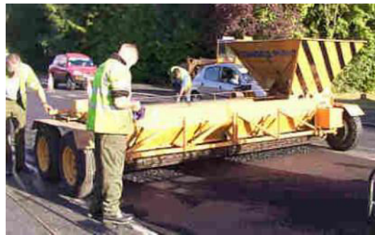
Εικόνα 3.8: Διάστρωση ψηφίδων στο θερμό ασφαλτόμιγμα
