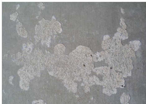
Εικόνα 2.16: Αποκόλληση αδρανών
