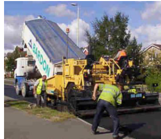
Εικόνα 3.7: Διάστρωση θερμού ασφαλτομίγματος
