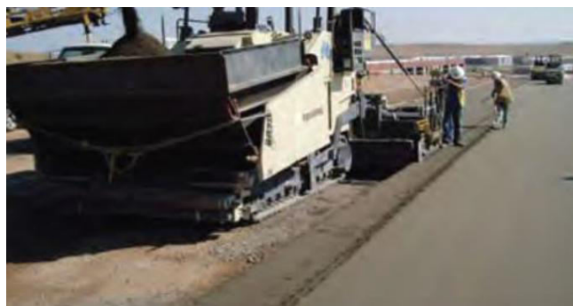
Εικόνα 4.2: Τοποθέτηση οδοστρώματος Roller – Compacted Concrete
