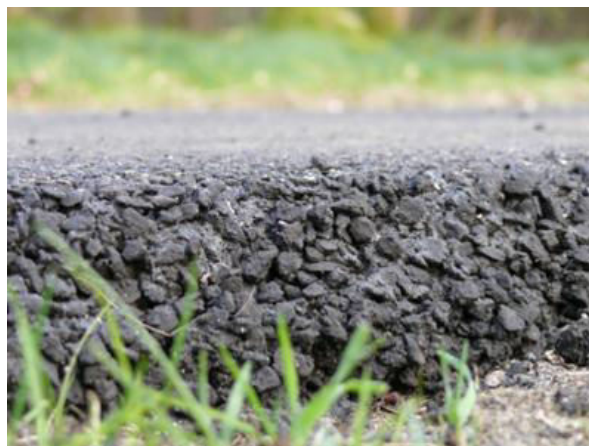
Εικόνα 1.6: Στρώση κρύου ασφαλτικού μίγματος
