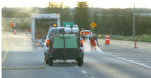
Εικόνα 3.4: Αμμοβολή σε οδοστρώματα (Sand blasting)
