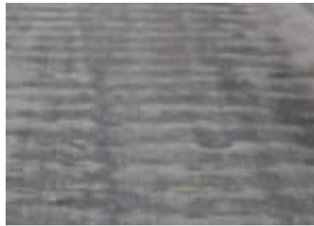
Εικόνα 2.9: Ρυτιδώσεις οδοστρώματος
