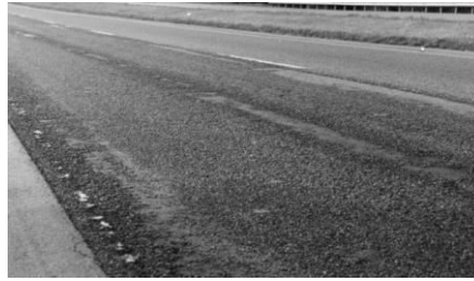
Εικόνα 2.11: Αποκόλληση αδρανών
