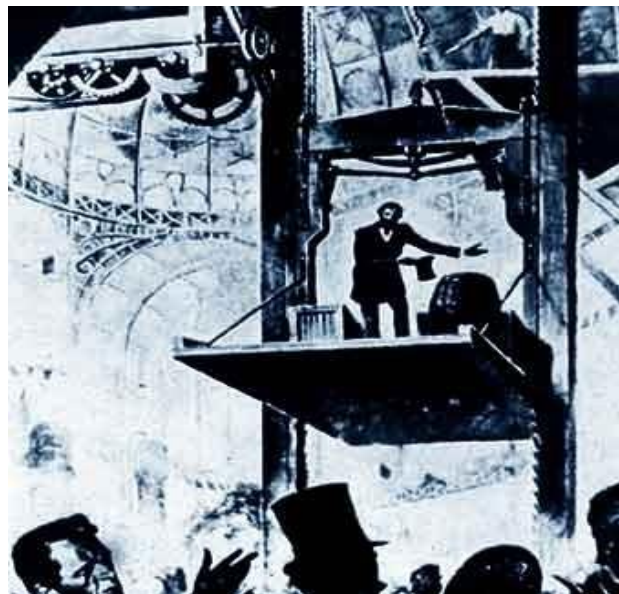
Σχήμα 1.8 Ανυψωτικός μηχανισμός της Otis.
