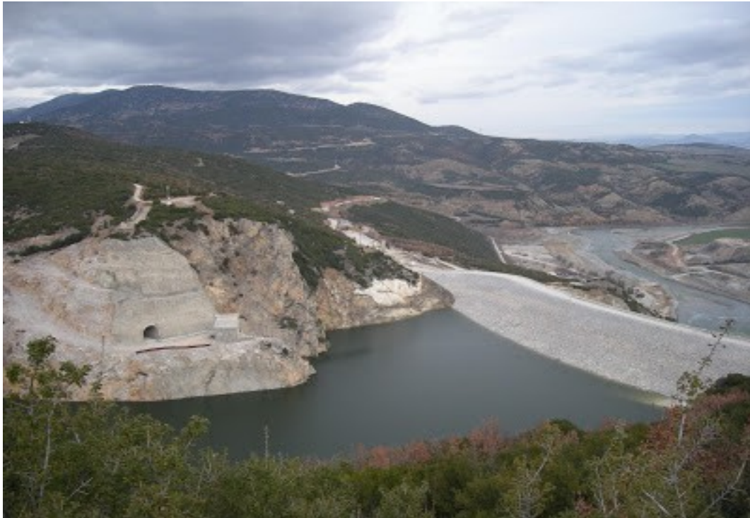
Η Μονάδα Νο1 του νέου Υδροηλεκτρικού Σταθμού (ΥΗΣ) Ιλαρίωνα της ΔΕΗ
