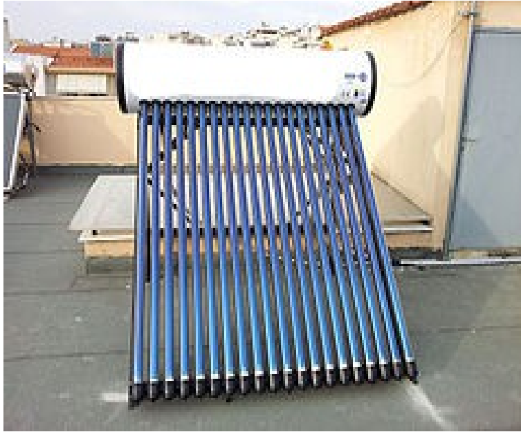
Χαμηλής θερμοκρασίας Ηλιακός θερμοσίφωνας με σωλήνες κενού, στην Θεσσαλονίκη
