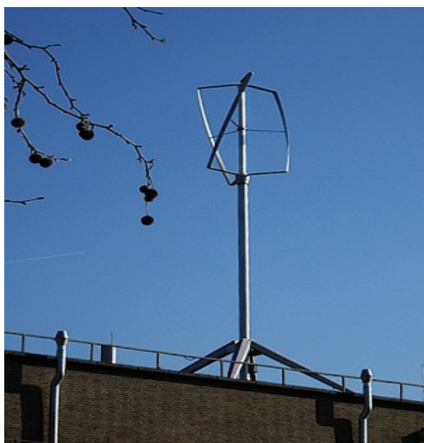
[Εικόνα 8] Ελικοειδής ανεμογεννήτρια Turby στην οροφή κτιρίου - See more at: http://www.zeroenergybuildings.org/2012/03/blog-post_17.html#sthash.08LUEyUH.dpuf
