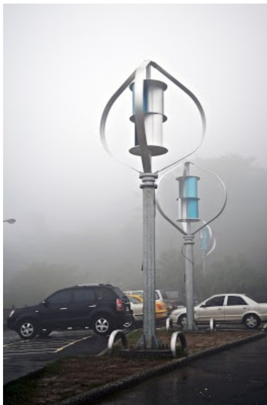
[Εικόνα 5] Συνδυασμός των τύπων Savonius και Darrieus σε μία ανεμογεννήτρια
