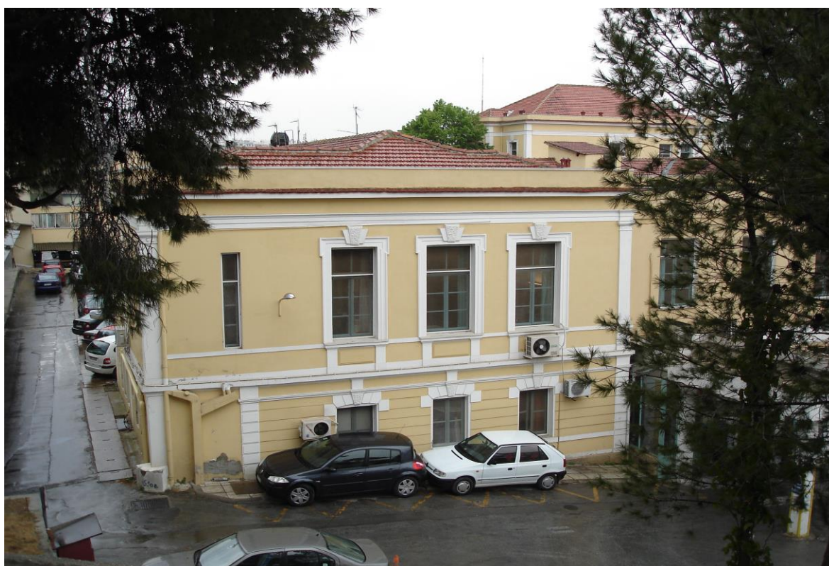
Εικόνα 3.8 Δυτική άποψη του Νοσοκομείου
