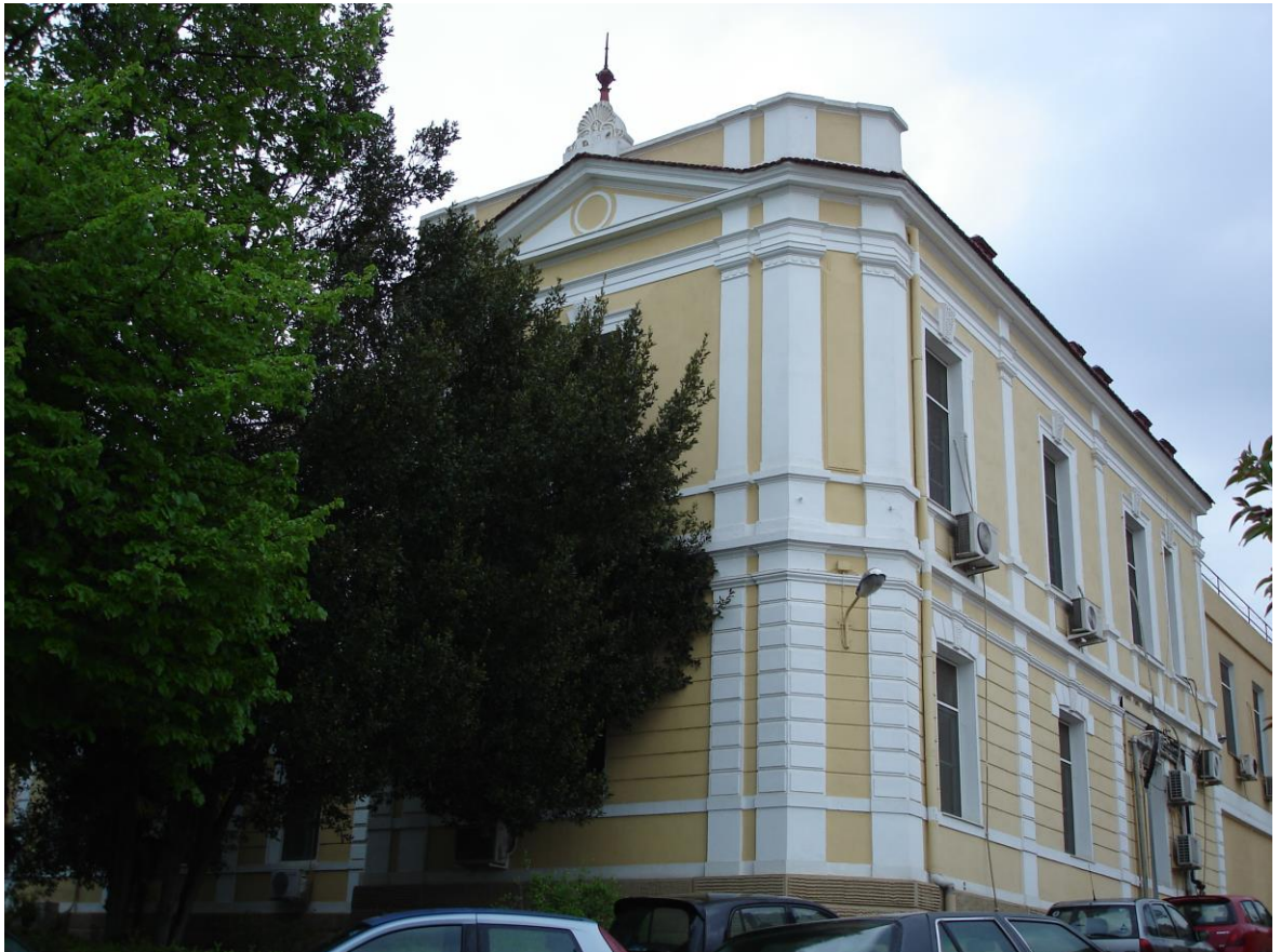
Εικόνα 4.1 Η δεξιά πτέρυγα του κτιρίου
