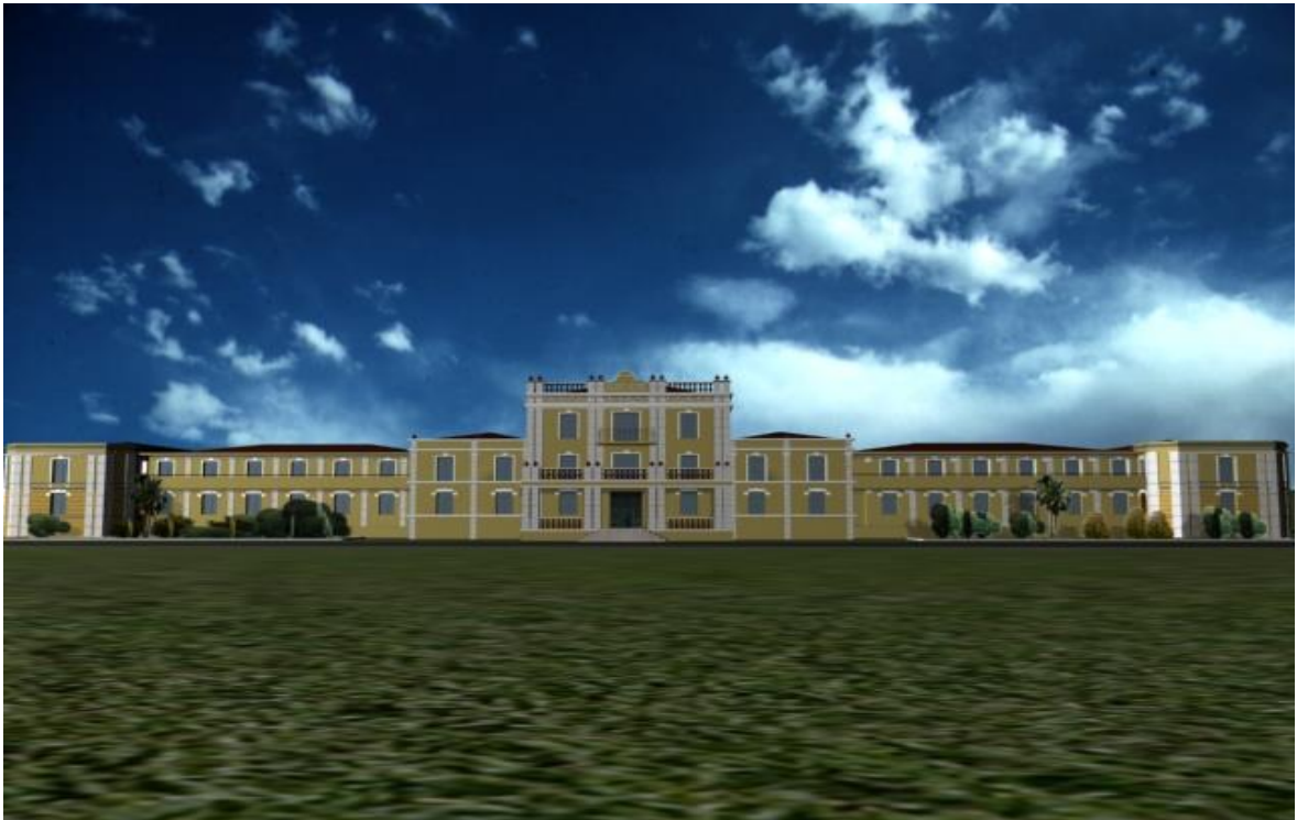
Εικόνα 6.33 Η πρόσοψη του κτιρίου
