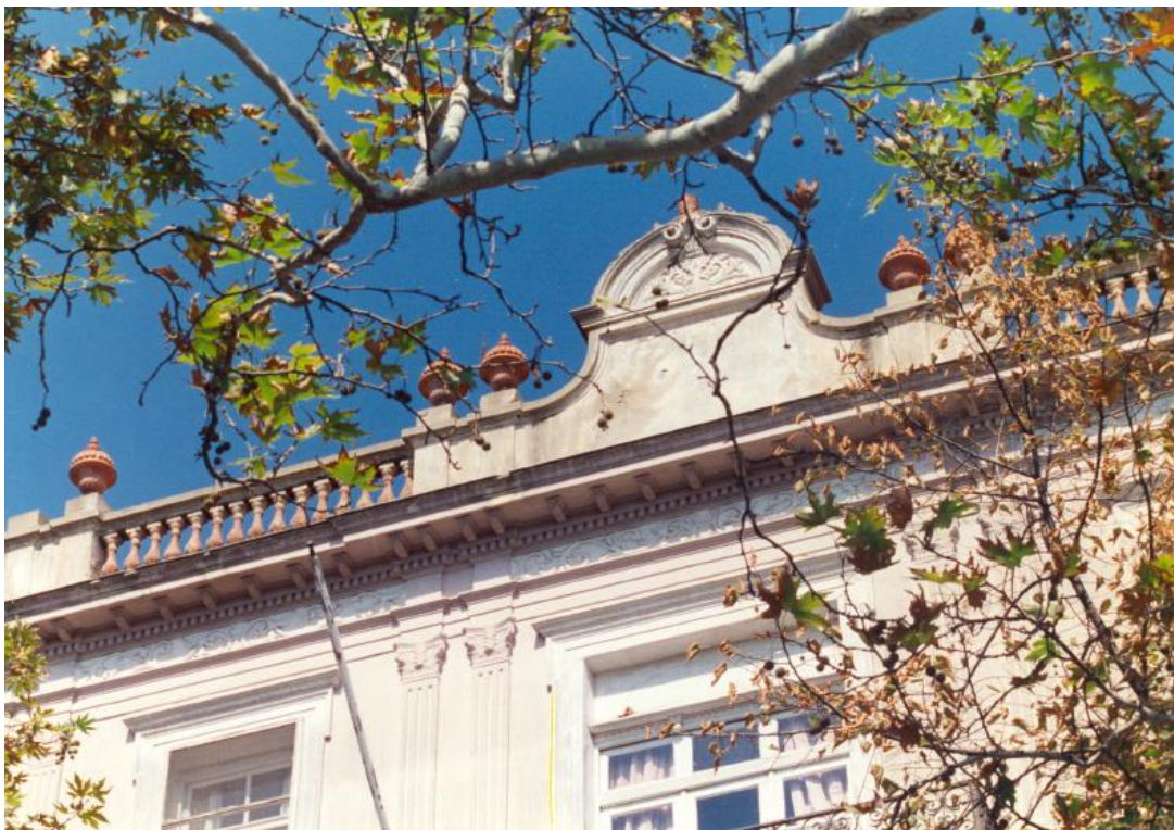
Εικόνα 4.2 Το καμπύλο αέτωμα με διακοσμητικά πήλινα στοιχεία και τα σιδερένια φουρούσια
