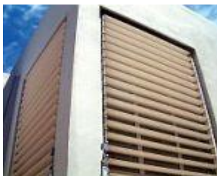
Σχήμα 4.2.2: Σκίαση κτιρίου με χρήση σκιάστρων
