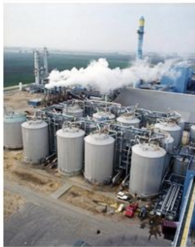
Μονάδα παραγωγής βιοαιθανόλης (www.nrel.gov) Αριστερά οι ζυμωτήρες - Δεξιά οι πύργοι απόσταξης
