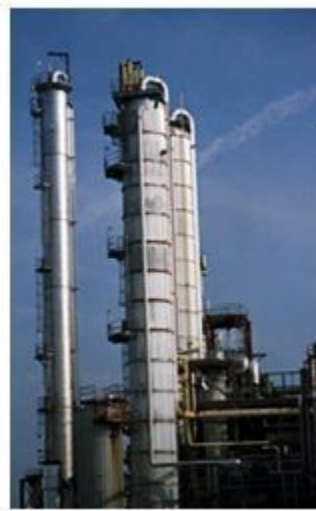
Μονάδα παραγωγής βιοαιθανόλης (www.nrel.gov) Αριστερά οι ζυμωτήρες - Δεξιά οι πύργοι απόσταξης
