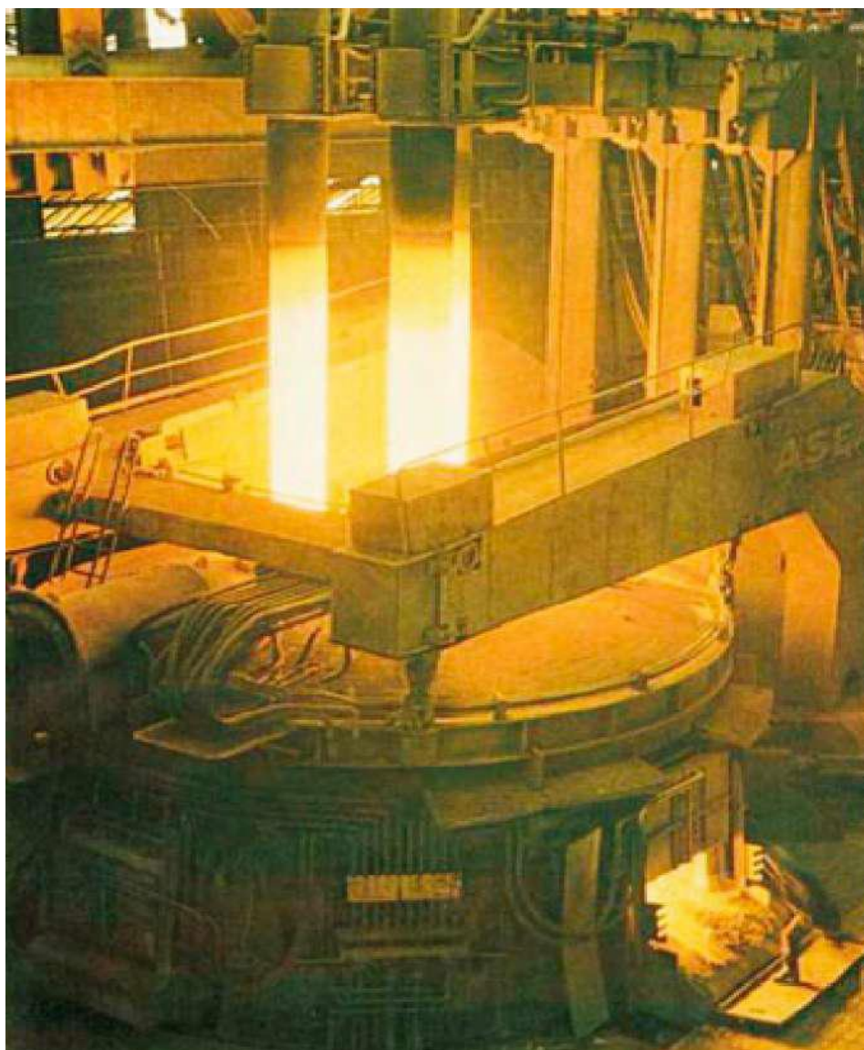
Σχήμα 1.4 Φούρνος ηλεκτρικού τόξου
